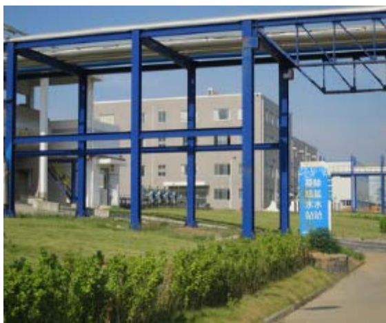
脱盐水处理站绿化
