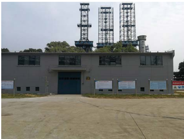
图 4.1-1 危废暂存场所
