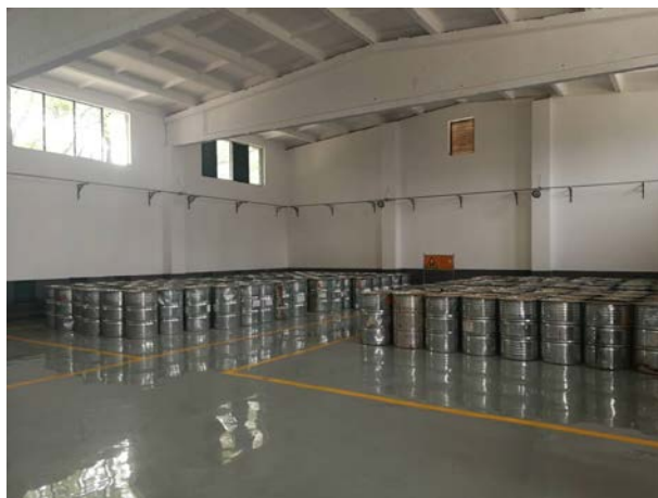
图 4.1-2 危废暂存场所
