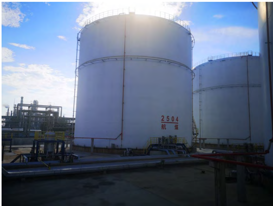
图 4.1-3 内浮顶储罐
