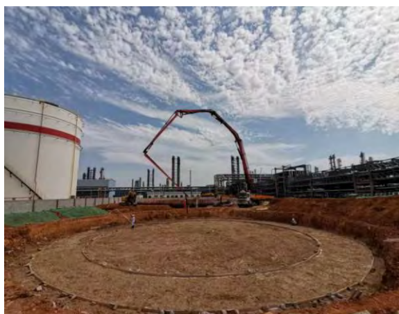
图 4.2-7 项目防渗施工 1
