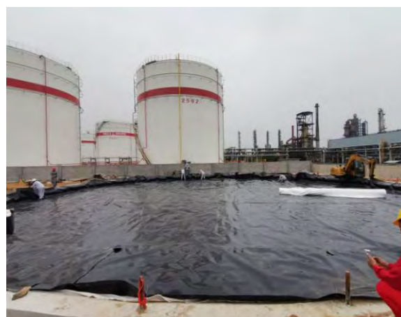
图 4.2-11 项目防渗施工 5
