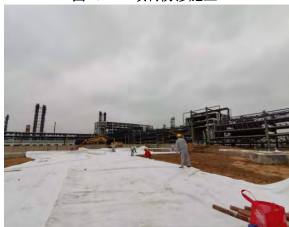
图 4.2-9 项目防渗施工 3
