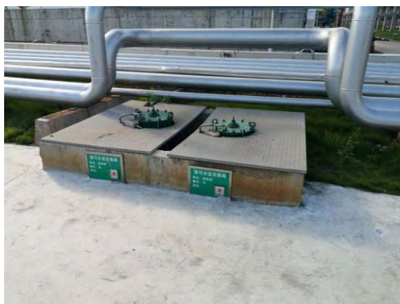
图 4.2-1 雨污分流切换阀
