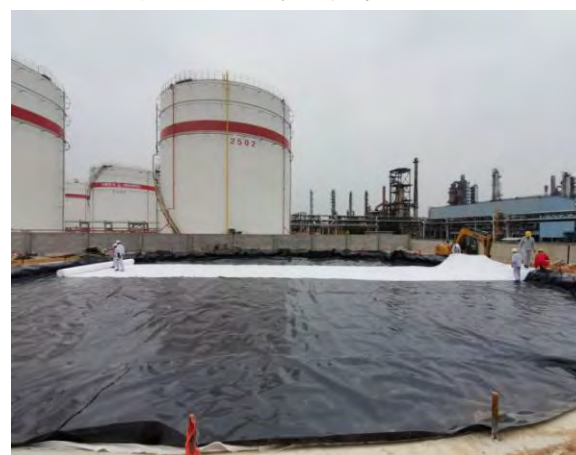
图 4.2-12 项目防渗施工 6
