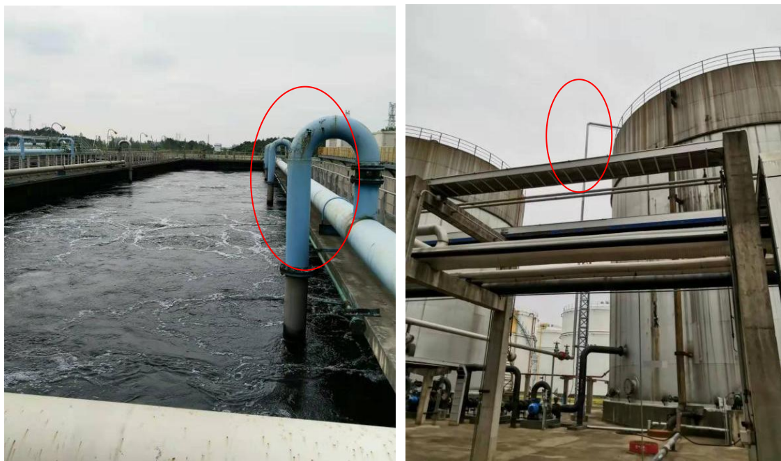
图 4.1-4 污水处理场污水、污油储罐呼吸废气改造情况
