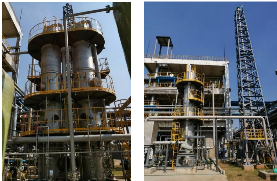
图 4.1-2 腈纶阻燃纤维聚合装置排气筒
