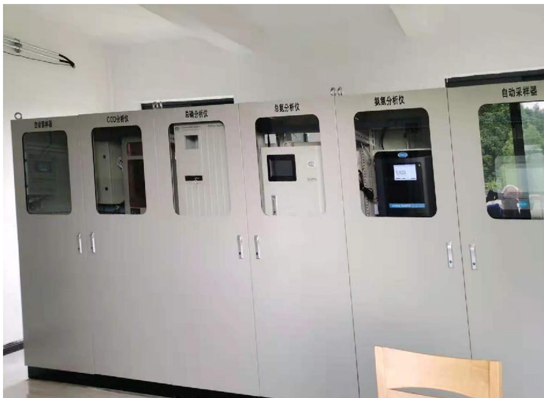
图 10.7-1 废水总排口在线监测设施
