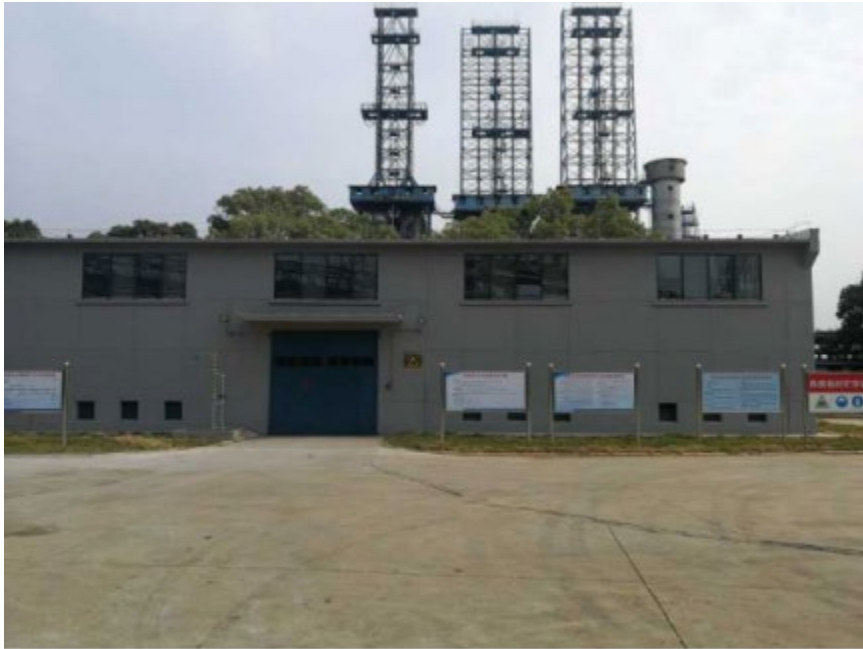
图 1 危废临时贮存场所
