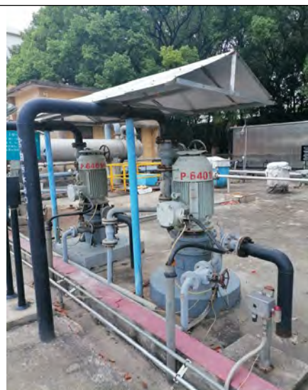
炼油一部I常减压和精制含油污水提升池和转输泵
