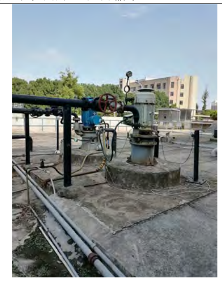
化工一部氨氮废水池和转输泵
