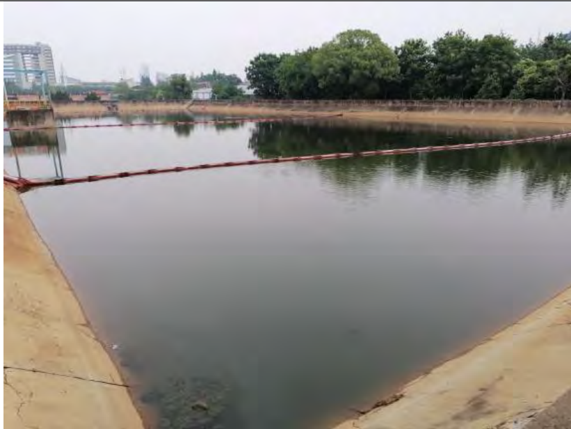
炼油老区雨水监控池
