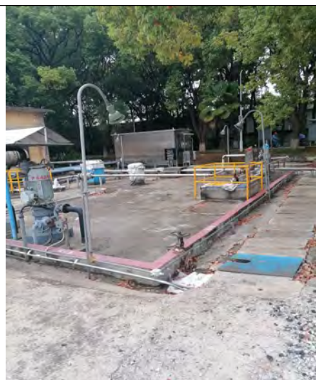
炼油一部I常减压和精制含油污水提升池和转输泵
