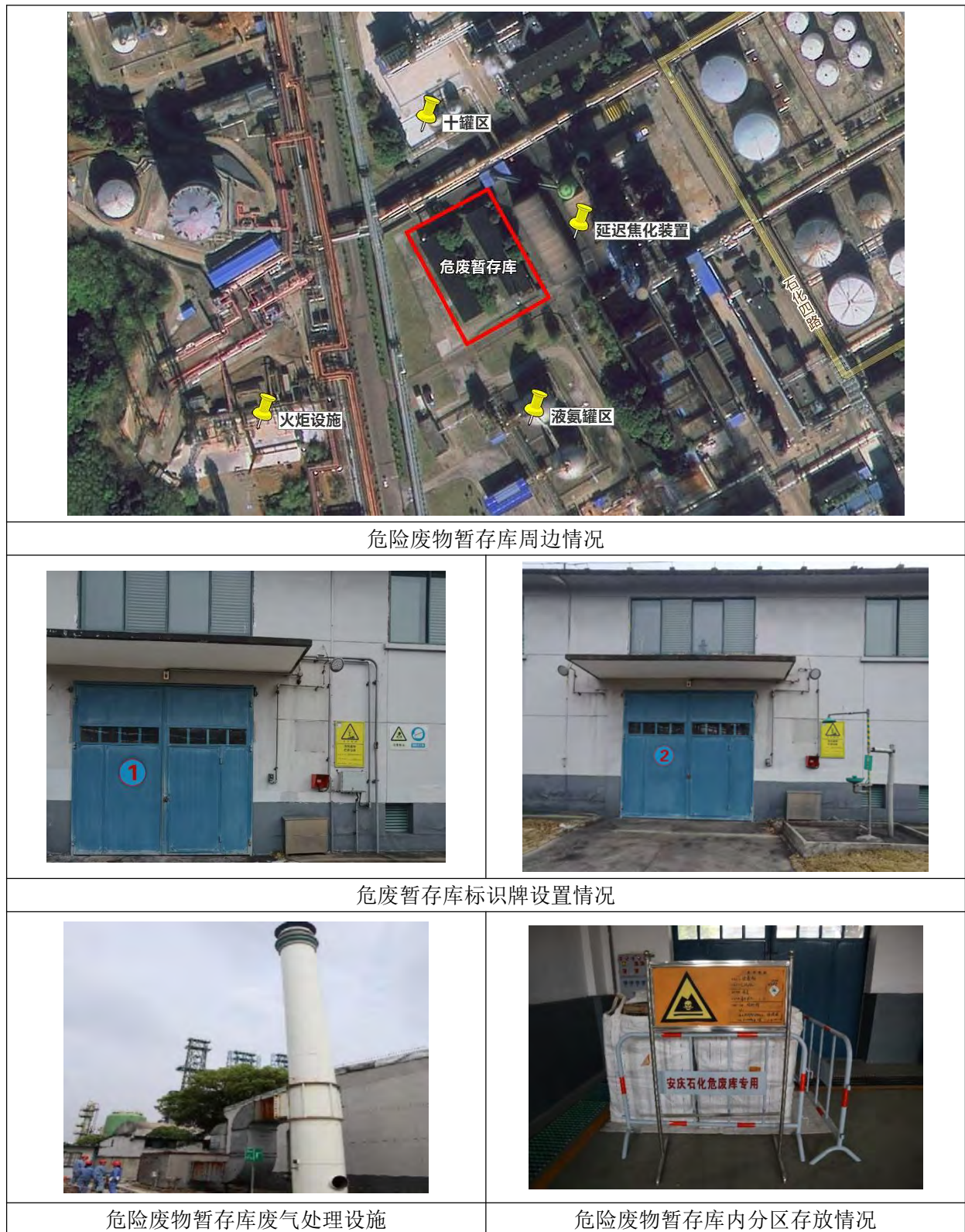
图 3.6-1 安庆石化危废暂存库
