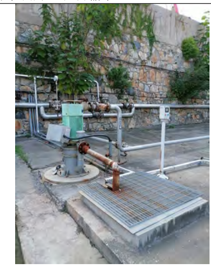
化工一部污水应急池和转输泵
