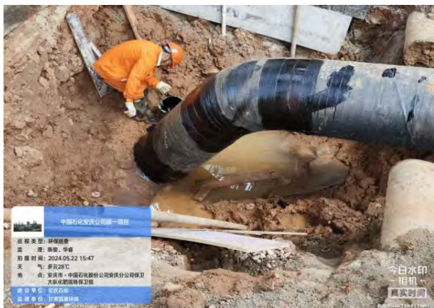
地下废水管线防腐防渗施工
