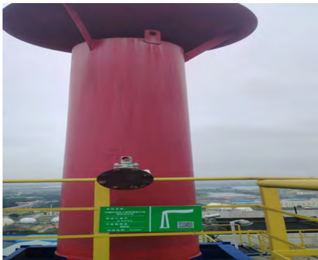
粉煤加压及输送废气新建 2 根 80m 高排气筒 (DA092、DA093) 采样平台、监测孔和标识牌
