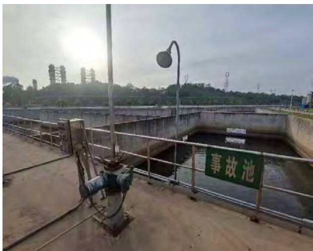
炼油新区现有 1 座 25000 m 3 事故池
