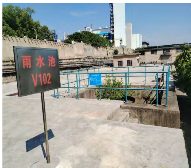
化工一部现有 1 座化肥雨水池（有效容积 1000m 3 ）
