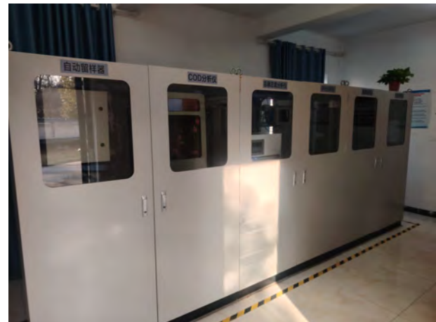
废水总排口现有在线监测设施
