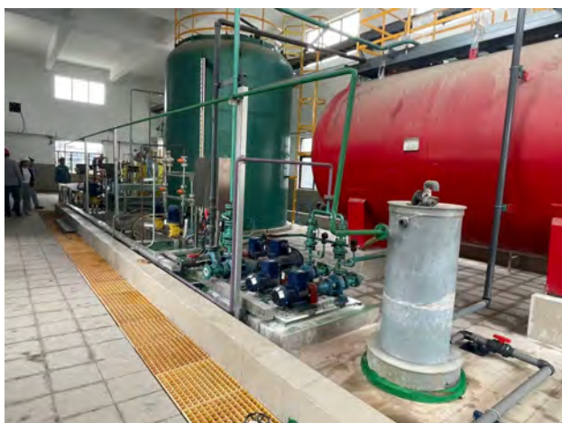
加药间围堰、导流沟、集液池
