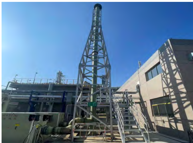
新建煤气化废水处理设施废气处理设施排口 DA095 采样平台+标识牌
