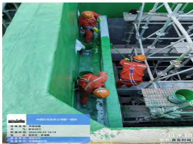
污水池池体防腐防渗施工
