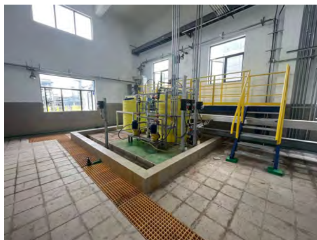
加药间围堰、导流沟、集液池
