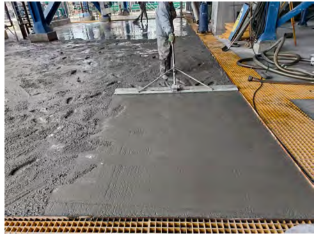
气化装置地面防渗施工
