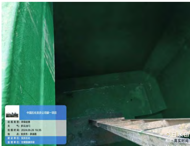
污水池池体防腐防渗施工
