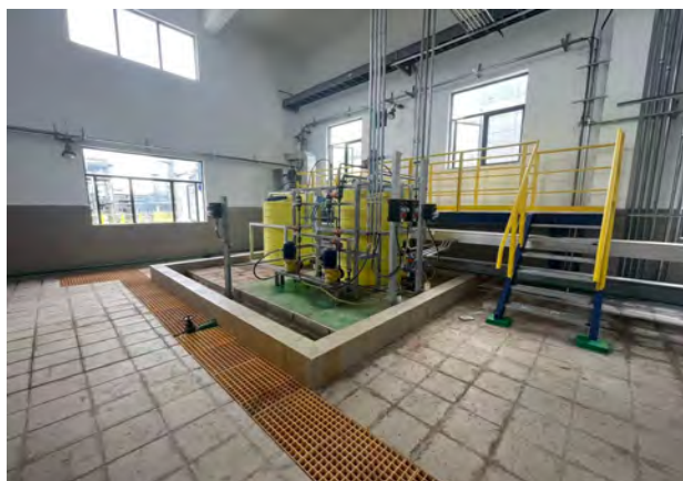
加药间地面防腐防渗
