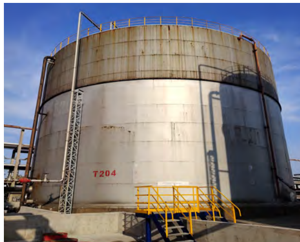
污水处理场现有事故罐 (10000m 3 )
