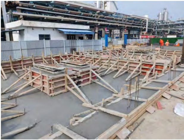
变电所事故油池防渗施工
