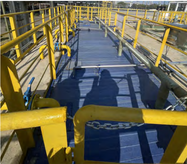
新建气化污水除氨氮设施废气密闭收集
