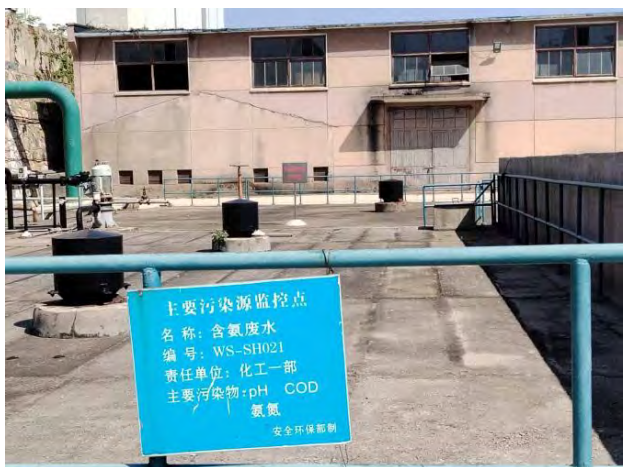
1 座氨氮废水池（有效容积 800m 3 ）
