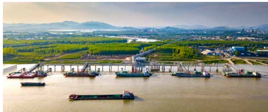
2019 年 1 月，安徽省“铸安”一号工程——新建危化品码头顺利投用。
