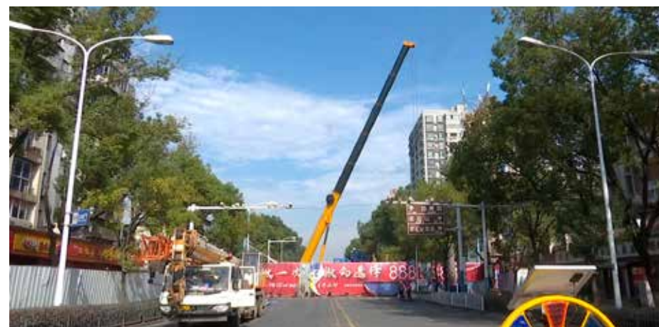
2019 年 11 月，横贯安庆城区的“8828”老管廊带、港贮码头和罐区圆满完成拆除工作，彻底消除了这一困扰多年的安全环保重大隐患。
